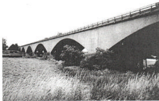
Beim Ausbau der A 6 wurde die Autobahnbrücke über den Neckar bereits erneuert
